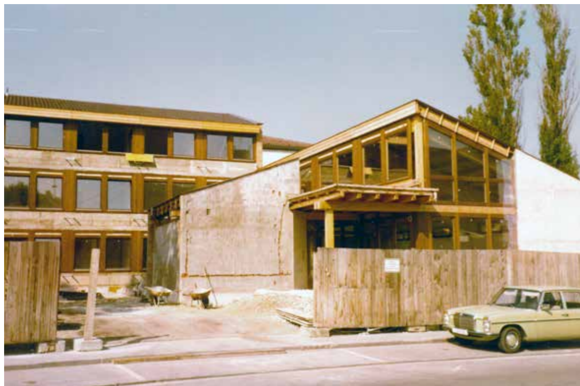
Im weiteren Baufortschritt nimmt auch der neue Eingangsbereich zwischen Saalbau (rechts) und Trauzimmer Gestalt an.
